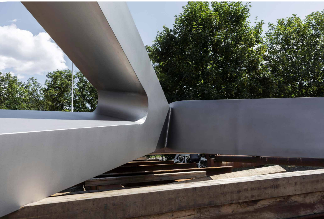
Photos des travaux de construction : Fonds Kirchberg - Christian Aschman
