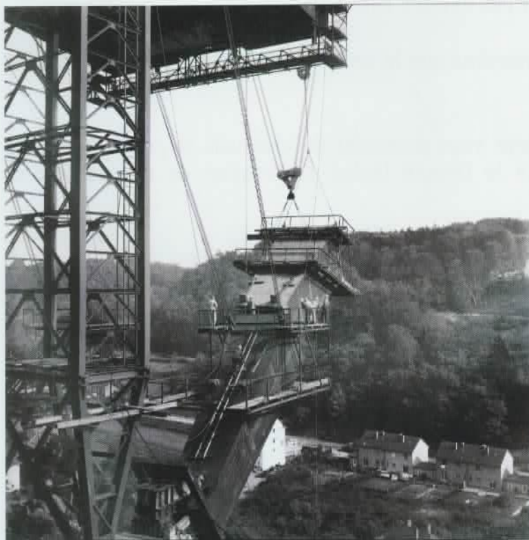
Construction du Pont Rouge, Léon Stirn, 1966 © Photothèque de la Ville de Luxembourg
