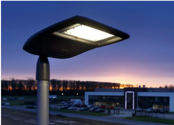
Abb. 43: Funktionalbeleuchtung Hansa-Businesspark, Münster Sensorik am Leuchtenmast, Beleuchtung fährt auf 100% bei Präsenzdetektion hoch, wenn 2 Minuten keine Bewegung stattfindet wird die Beleuchtungsstärke abgesenkt.
