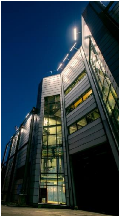
Abb. 44: Gas- und Biogaskraftwerk in Schwerin mit neuer LED Beleuchtung. Die Fassadenleuchten strahlen von oben nach unten, Himmelsaufhellung wird so vermieden. Ein positives Image der Stadtwerke soll durch die emissionsarme Beleuchtung transportiert werden.
