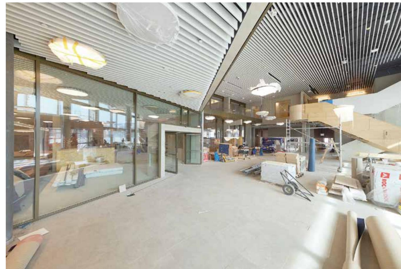
Die Teppichverlegung in den öffentlichen Bereichen wurde in zwei Arbeitsschritten unterteilt. Die Bereiche zwischen den Regalreihen im Lesesaal wurden erst nach dem Bücherumzug verlegt, damit der Umzug reibungslos und ohne besonderen und aufwendigen Bodenschutz durchgeführt werden konnte.
