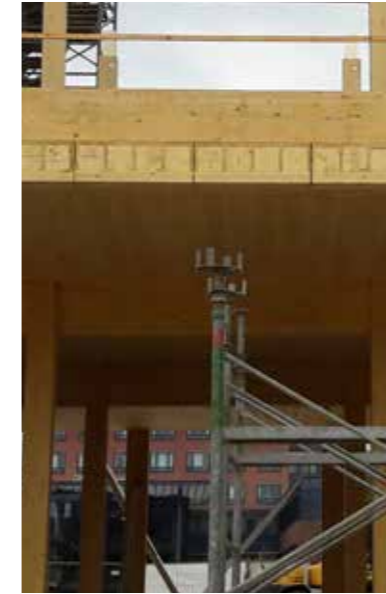
↘ Holzskelett während der Montage
