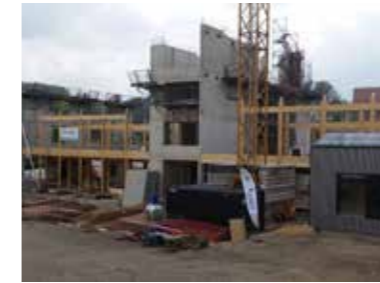
< Montage des Holzbaus
