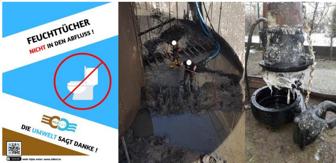
**Abbildung 9:** Hinweis des Abwassersyndikates SIDEST zur Problematik der Vliesstofftuchentsorgung mit der Toilettenspülung und Fotos zu Beeinträchtigungen der Abwasserreinigung durch solche Tücher (Quelle: SIDEST und Pent air -Jung Pumpen)
