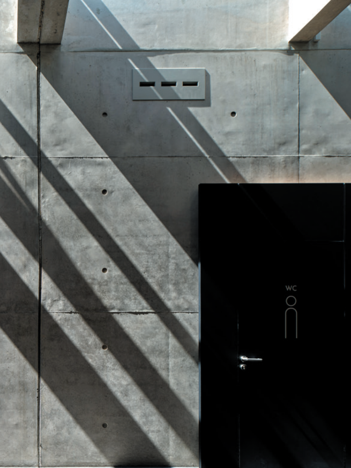
Die tragenden Wände sind ganz aus Beton gebaut
