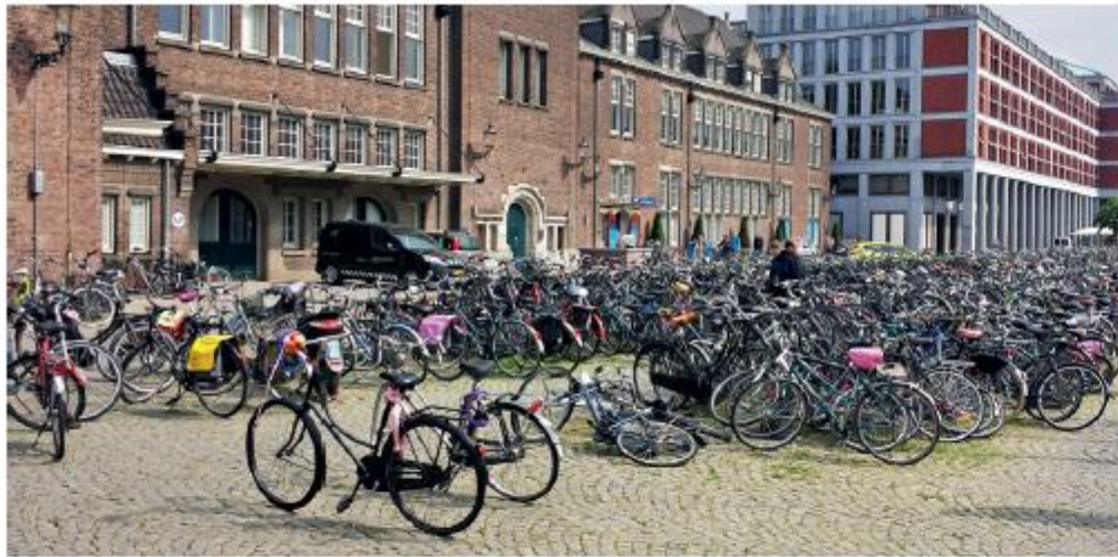
Maastricht: Bahnhofsplatz vor dem Bau des Parkhauses
