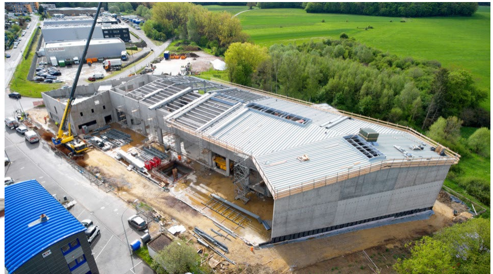
Chantier SICA – © Commune de Kehlen
