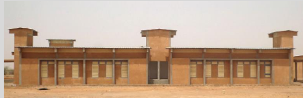
Cheminées solaires, Cooperation luxembourgeoise au Niger, 2016
