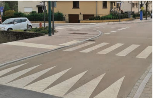
Carrefour surélevé avec revêtement clair
