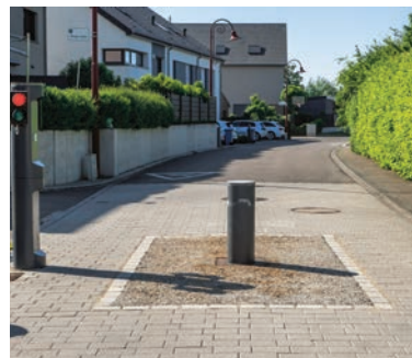
Impasse franchissable aménagée avec une borne escamotable
