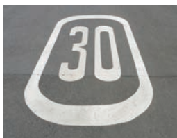
Marquage au sol du signal C,14
