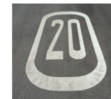
Marquage au sol du signal C, 14
