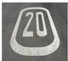
Marquage au sol du signal C, 14
