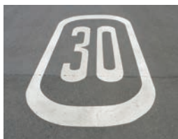
Marquage au sol du signal C,14
