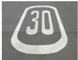
Marquage au sol du signal C,14
