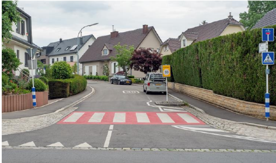
Transition avec un marquage (aménagement à ne plus prévoir)
