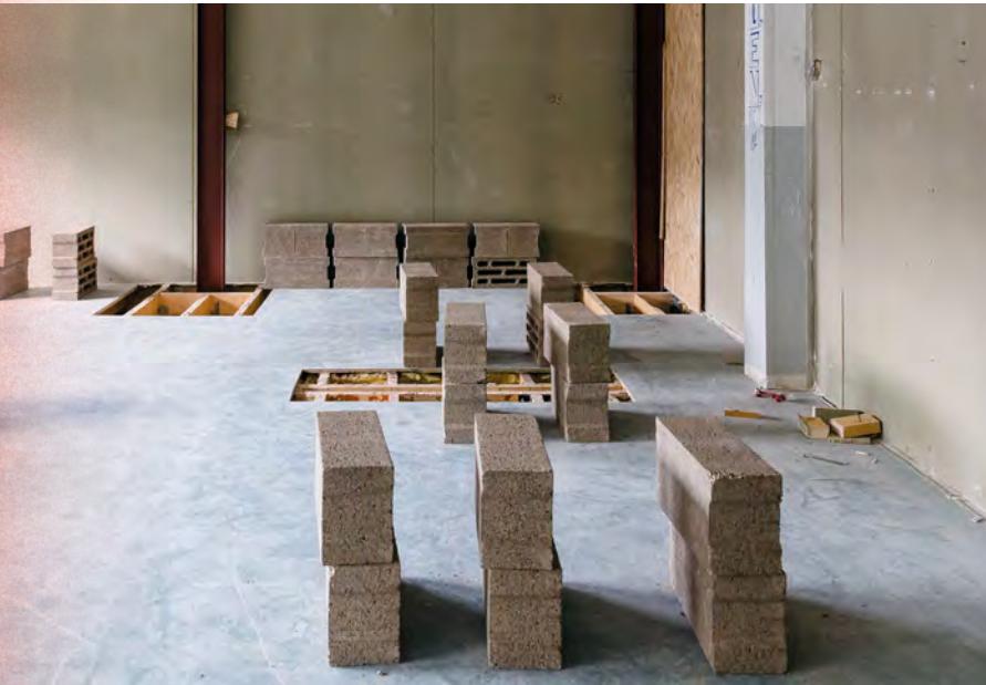
Création des ouvertures dans le plancher du rez-de-chaussée pour les nouvelles fondations.
