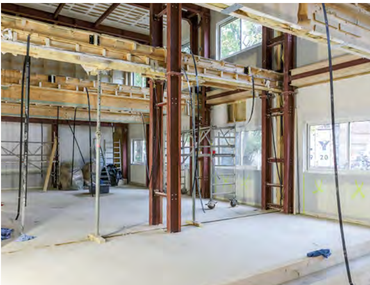
Démolition du plancher et des anciens murs en bois dans la future salle de lecture à double hauteur.
