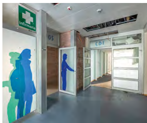
Après la libération du bâtiment et un nettoyage sommaire, les luminaires ont déjà été démontés pour être réutilisés dans l'aile 6000.
