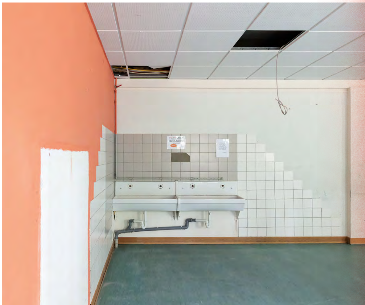
Après la libération du bâtiment et un nettoyage sommaire, les luminaires ont déjà été démontés pour être réutilisés dans l'aile 6000.
