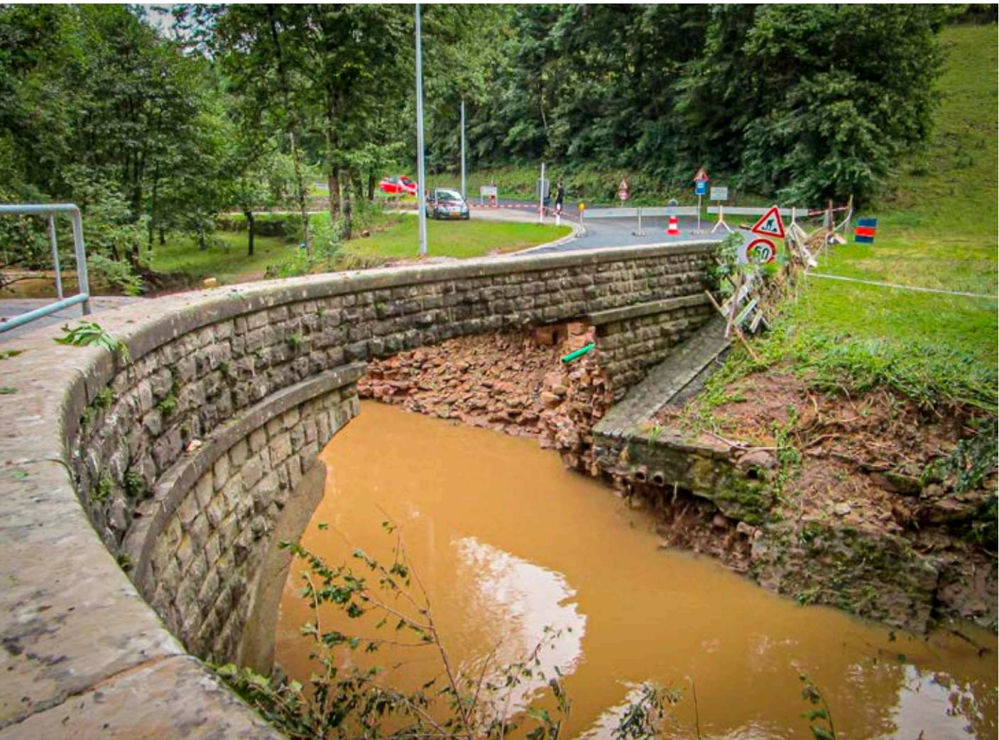
**Schwere Schäden an einer Brücke über der Weißen Ernz bei Hessemillen nach einem Starkregenereignis im Jahr 2016.**
