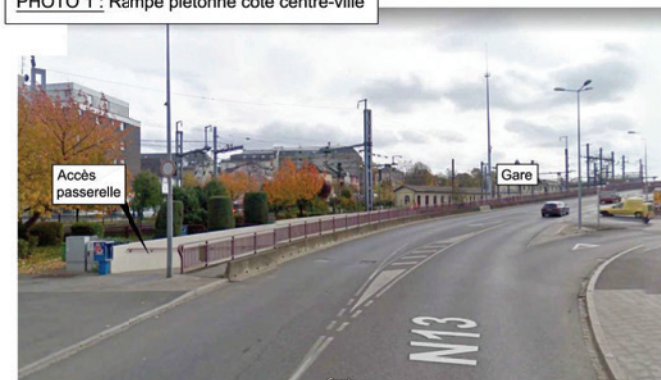
PHOTO 1 : Rampe piétonne côté centre-ville
