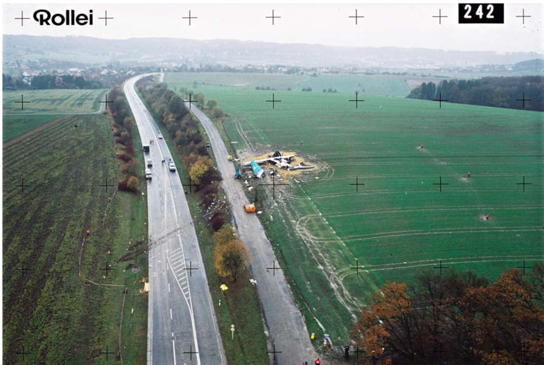
Vue aérienne de la route nationale 1 et du site
