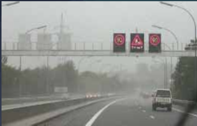
Panneaux à signalisations variables
