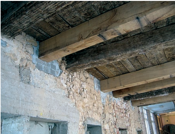
Ancrage de nouvelles poutres pour stabiliser l'ancien plafond
