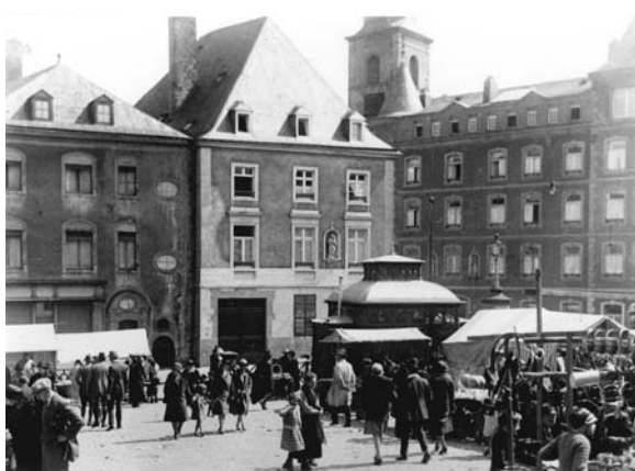
La toiture du n° 4 rue Wiltheim refaite après un incendie
