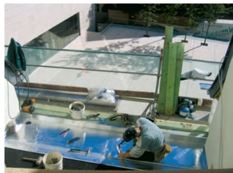
Réfection des toitures
