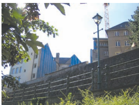
Îlot A: les travaux en cours derrière le rempart descendant à plus de 12 m
