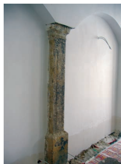
Les baies aveugles, découvertes au 2 e étage, datent de la Renaissance
