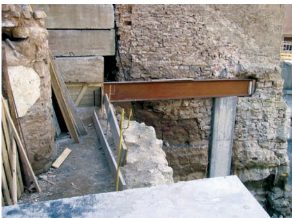
Reprise en sous-œuvre, côté Schéieschlach
