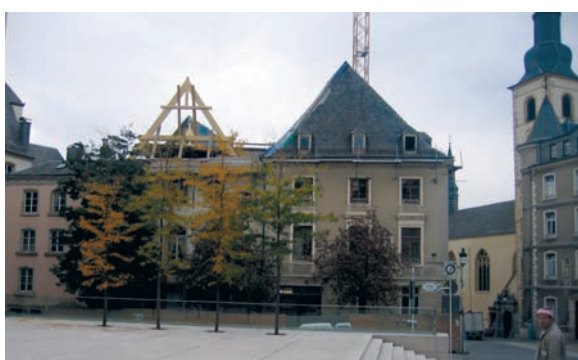
Rétablissement de la charpente, conformément à la silhouette d'origine des toitures
