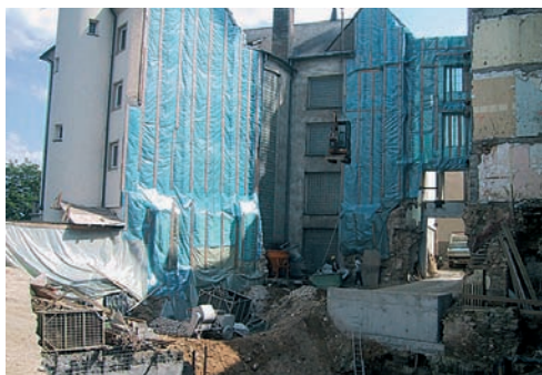
La démolition de l'annexe de la Clinique Saint-Joseph permet la construction du parking souterrain et de la nouvelle aile du Conseil d'État
