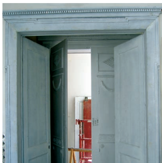
Une porte à double battant, début XIX e , après restauration
