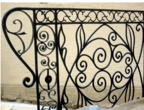
La maison 11 : garde-corps restauré
