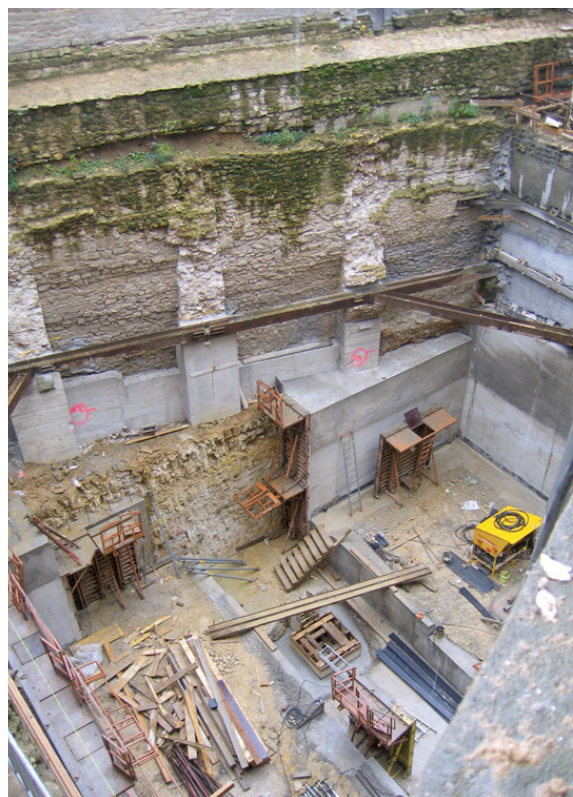
Les fondations du nouveau parking
