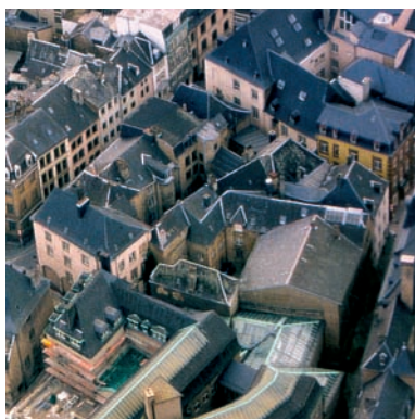
Îlot B: Vue aérienne sur un quartier délaissé
