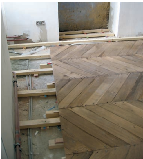
Pose du parquet neuf sur lambourdes
