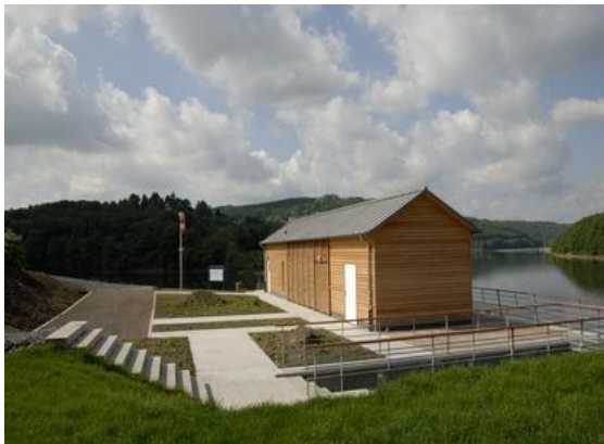
Pavillon de la Protection Civile
