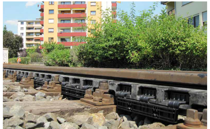
Exemple de « raildampers » (amortisseurs de rail).
