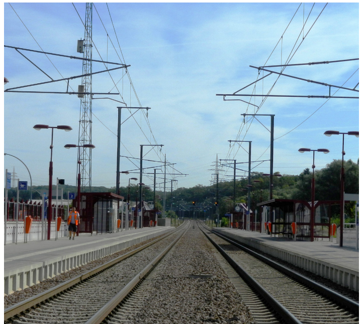
après les travaux
