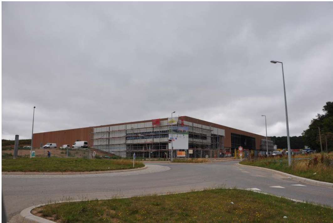
Le centre commercial en construction de Redange-sur-Attert (photo : Valérie Feltgen)
