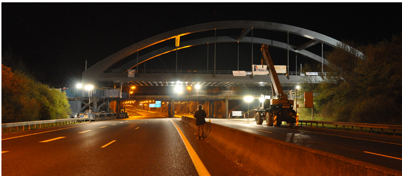
Ripage du pont du type Bowstring au dessus de l'A6 en 2008.
