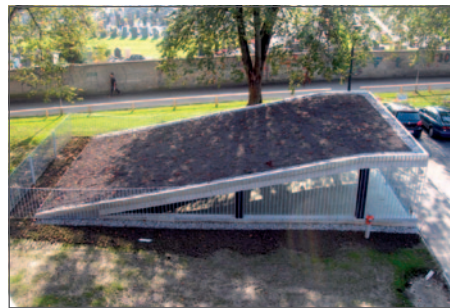
▲ Wohnanlage Sandgrubenweg, Bregenz (A)
