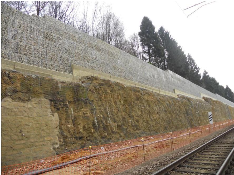
Murs de soutènement en gabion en crête et mur de confortement en maçonnerie en pied de paroi
