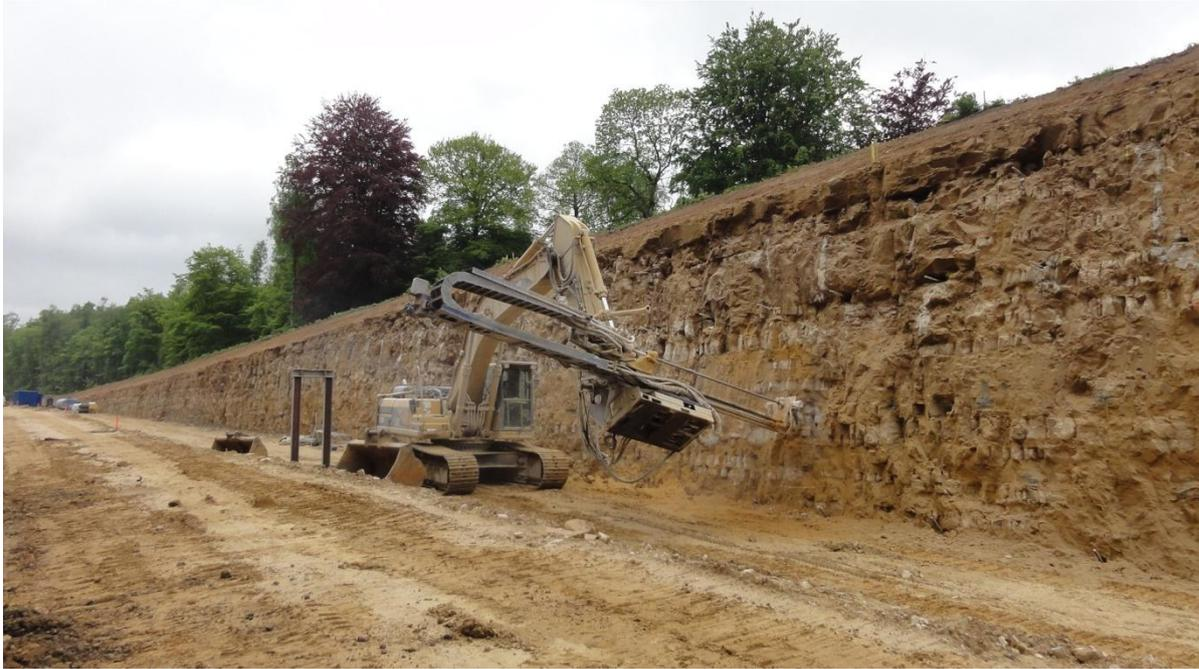
Forage de clous et de tirants d'ancrage comme mesures de sécurisation des parois rocheuses
