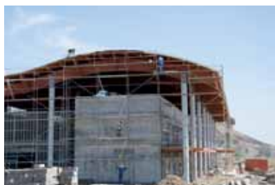
Cabo Verde - Construction du centre ERMI, centre de formation professionnelle en matière d'énergies renouvelables
