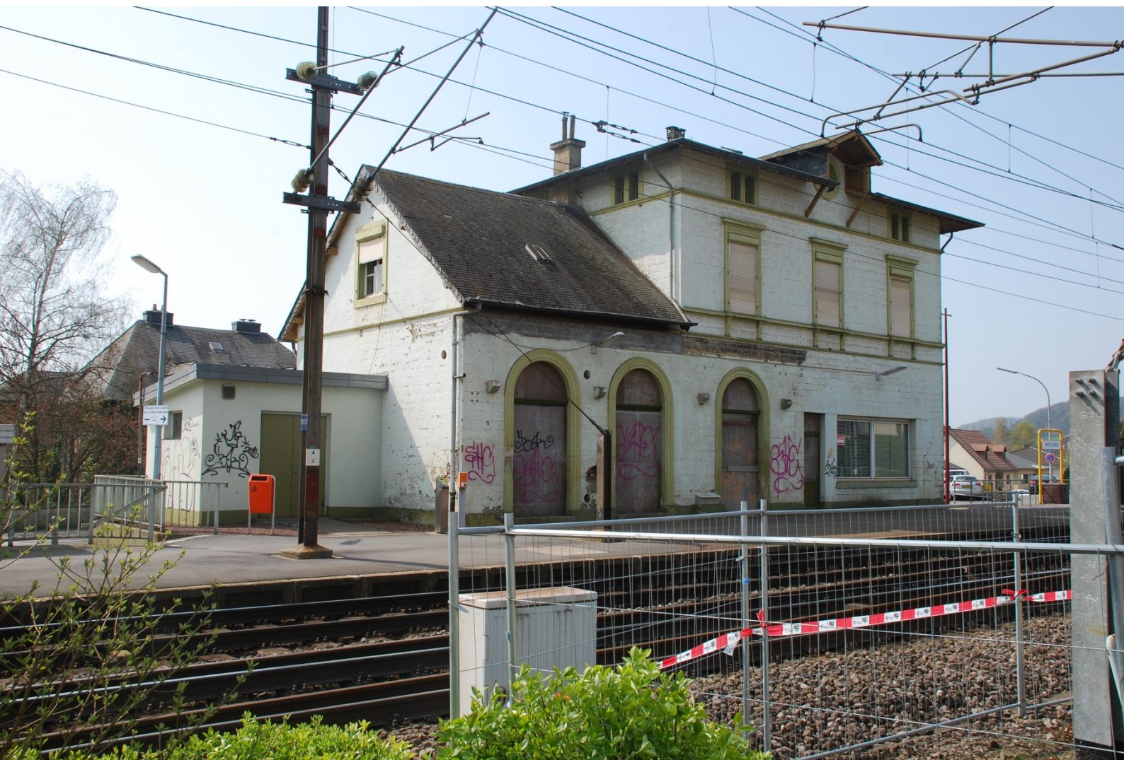
la gare avant réhabilitation
