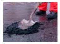
Pour la réparation on utilise généralement des asphaltes froids. Souvent les réparations ainsi faites sont de courte durée à cause de leurs sollicitations permanentes sous les effets de la circulation.
