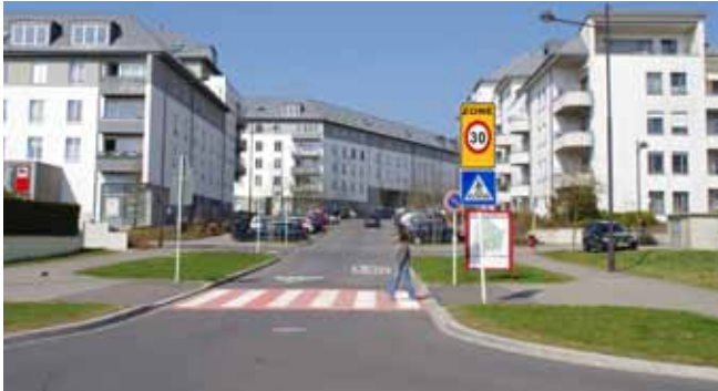
entrée en zone 30km/h - largeur de la chaussée inférieure ou égale à 5m
