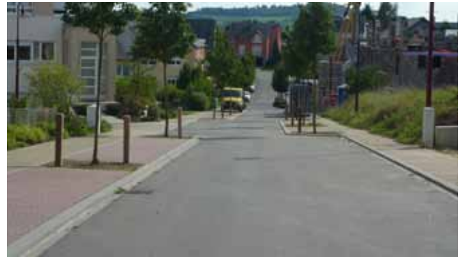
rétrécissement de la chaussée au moyen d'une bande de stationnement construite et alternée
