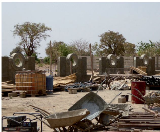
◀ Construction du CRTS de Ouagadougou
