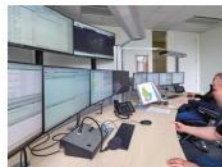
1. Poste de commande (Verkeiersverbond)
