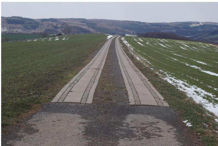
Figure 2 : chemin d'exploitation stabilisé par dalles en béton
