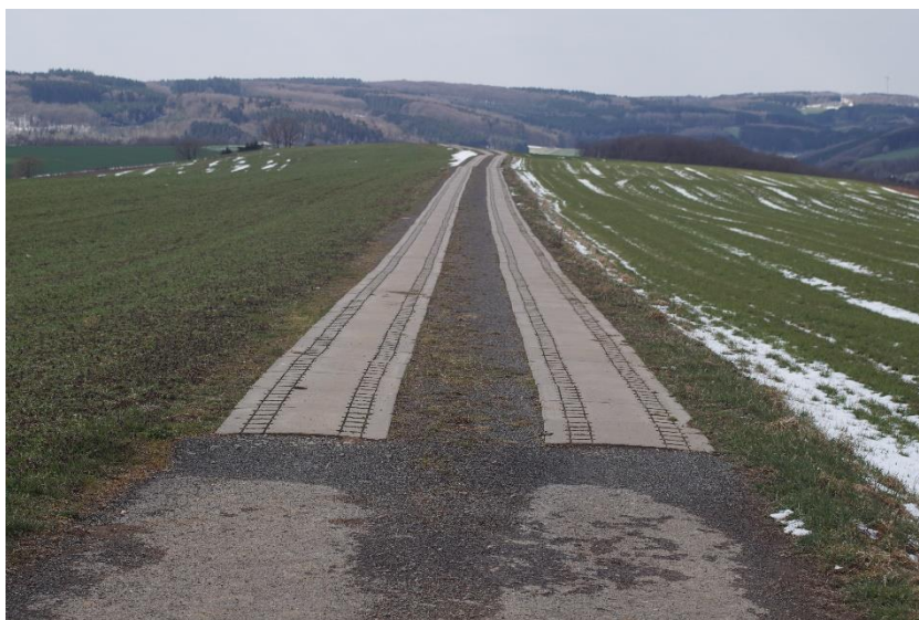
Figure 2 : chemin d'exploitation stabilisé par dalles en béton
