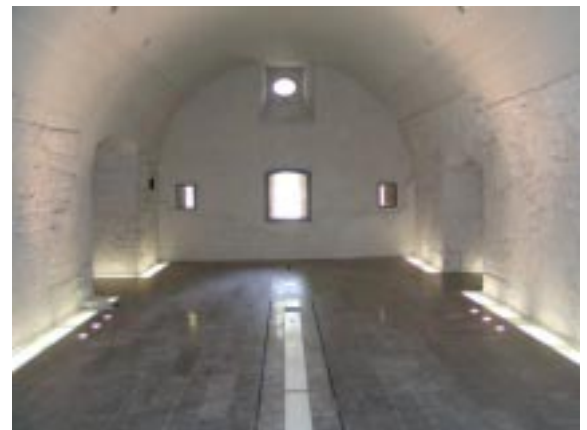
Travaux d'isolation sonore et installation des encoches de mobilier
