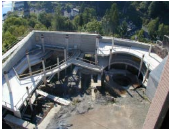
Centre de formation (première partie) - dalles - rampes, juillet 2003
