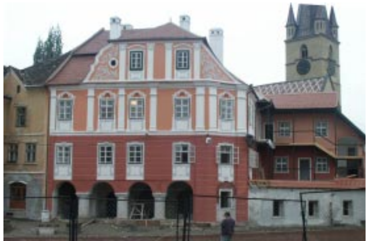
CASA LUXEMBURG (La Maison du Luxembourg) La partie gauche de la façade et l'annexe à droite s'étaient effondrées et ont été reconstruites
