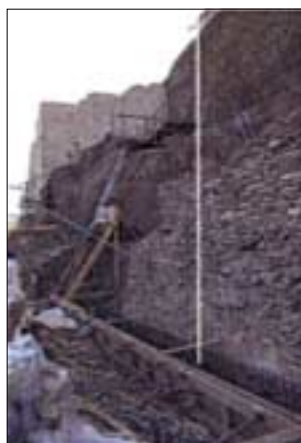
Zones fortement déstabilisées et nécessitant des renforts en béton armé
