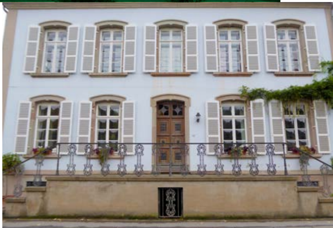
Maison à Useldange, classée monument national
