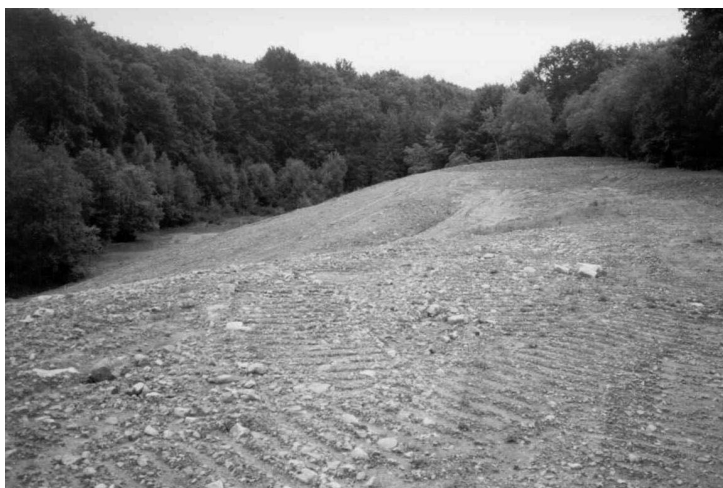
Décharge de Dippach: talus de la décharge après réaménagement, prêt pour être reboisé
