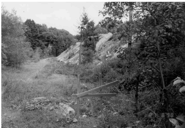
Décharge de Dippach: talus de la décharge avant réaménagement
