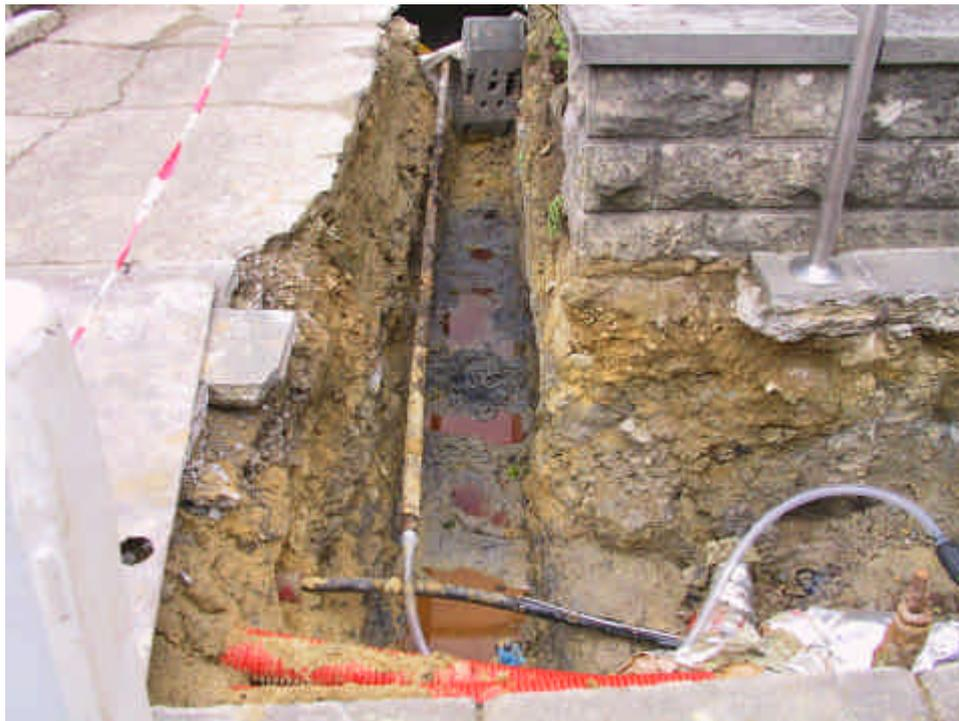
Mazout provenant d'un réservoir défectueux dans une tranchée
