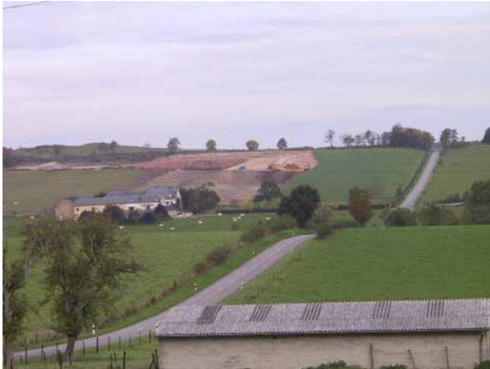
Décharge de Folkendange avec à droite, une phase exploitée et réensemencée, au milieu une phase en exploitation et à gauche les phases en attente d'être exploitées.
