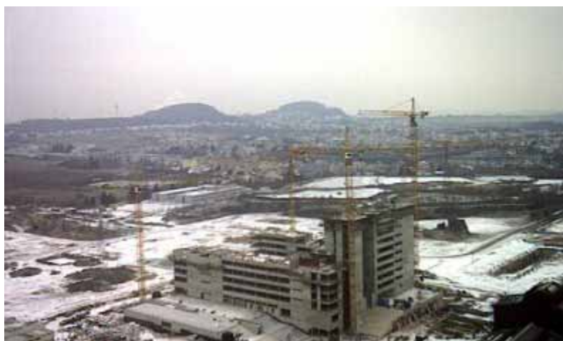
Chantier de la DEXIA – BIL à Esch – Belval
