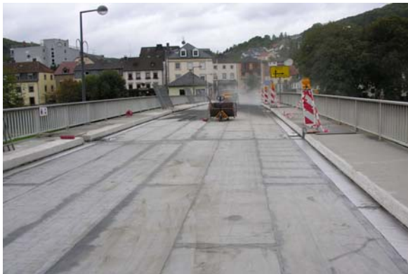
Nouvelle étanchéité mise en place
