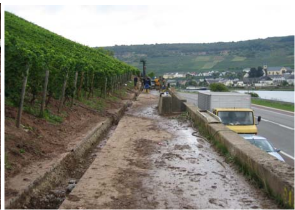
Protection cathodique : Mise en place d'anodes forées
