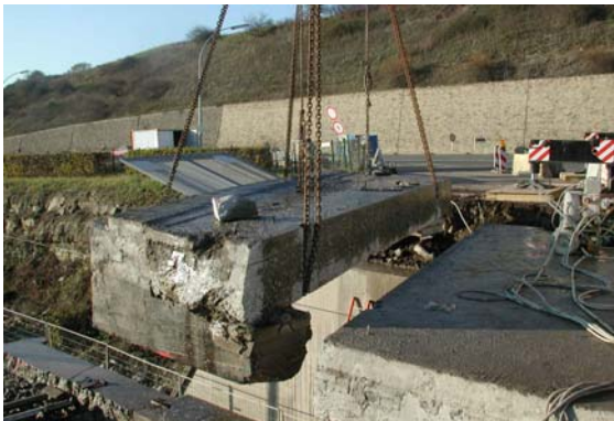
Levée d'une partie de l'ancien tablier de l'OA794
