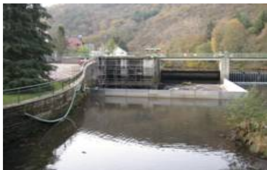
Barrage secondaire N°2
