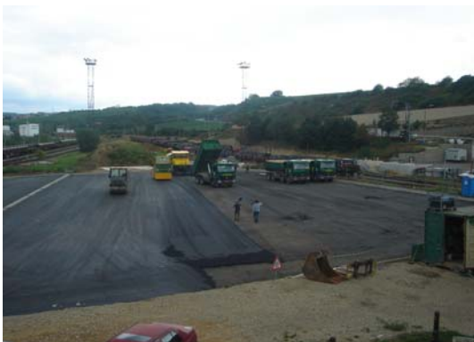
Construction parking poids-lourds
