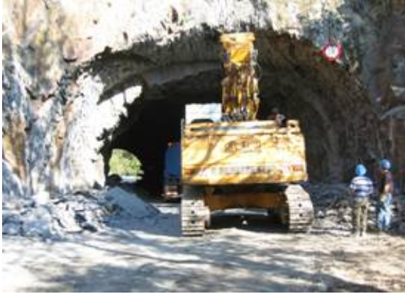
Agrandissement du gabarit routier
