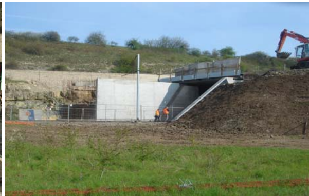
Nouveau tablier avant la coulée de béton
