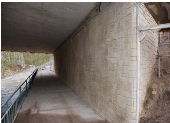
Béton projeté à structure de maçonnerie
