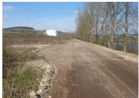
Aménagement sortie de secours
