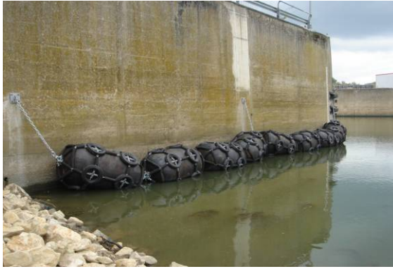
Protection du mur du quai sud.
