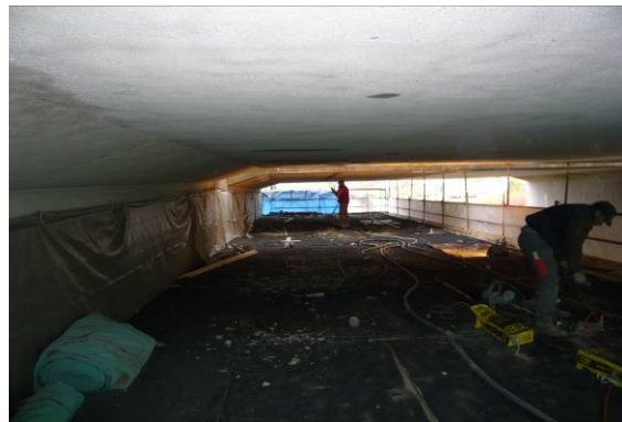
Réfection de l'intrados du tablier de l'OA 1106 à Pontpierre
