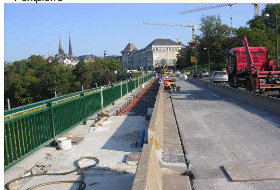
OA 788 Passerelle – réfection trottoirs et aménagement piste cyclable
