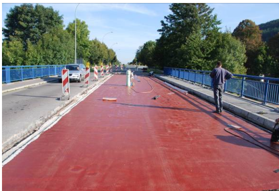
Remplacement de la superstructure de l'OA 233 à Colmar-Berg
