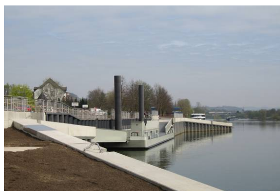
Nouveau quai d'accostage avec ponton flottant
