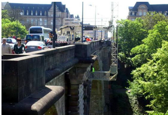
Inspection du Pont Adolphe - OA750
