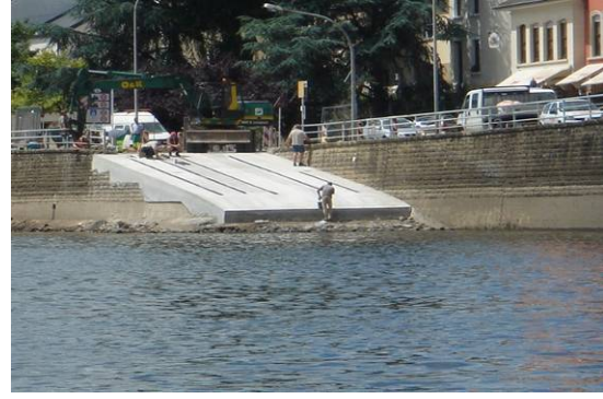
Renouvellement de la rampe du bac à Wasserbillig
