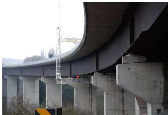
Inspection du Viaduc de Sernigerbach - OA1134
