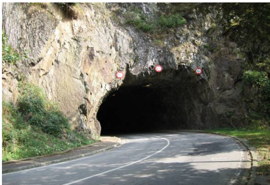
Tunnel avant travaux
