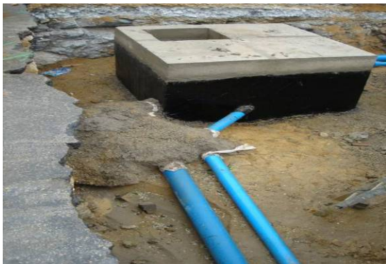
Renouvellement de l'alimentation en eau
