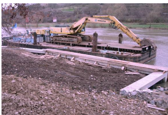
Terrassement le long du chenal navigable
