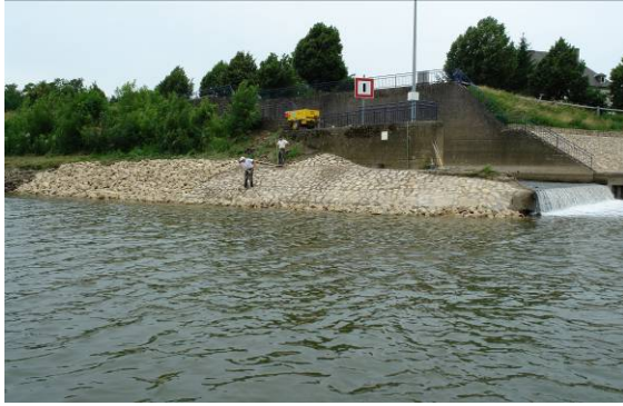
Colmatage des affouillements du musoir au port de Mertert.
