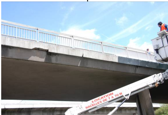
Sécurisation de l'A4
