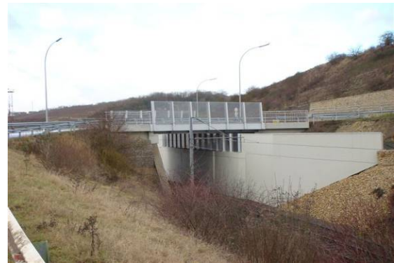
Pont après achèvement du chantier
