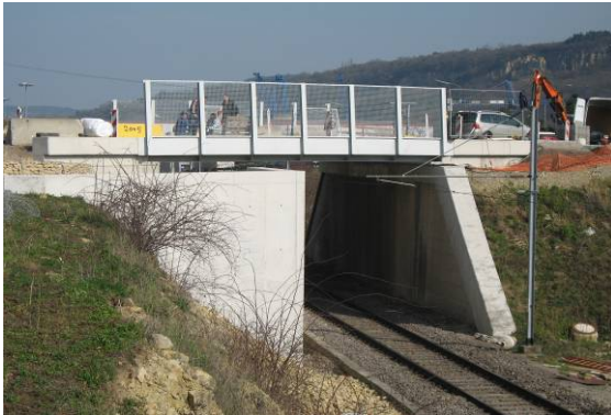
Mise en place étanchéité sur les trottoirs
