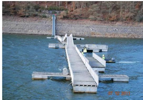
**Pont flottant OA 1424 avec travées de rive démontées**
