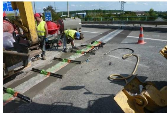
**OA 1065 Triage - remplacement joint de chaussée**
