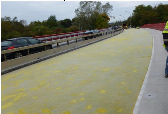
OA 1052 Cessange - Remise en état de l'étanchéité du tablier avec remplacement d'appuis et des joints de chaussées
