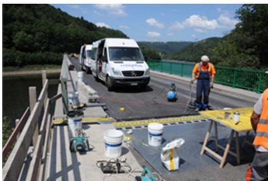
OA115 Bivels : mise en place de nouveaux joints de chaussées sur culées
