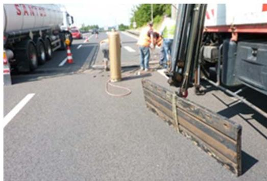
OA1025 Livange et 1037 Helfenterbréck : remplacement d'éléments de joints de chaussées
