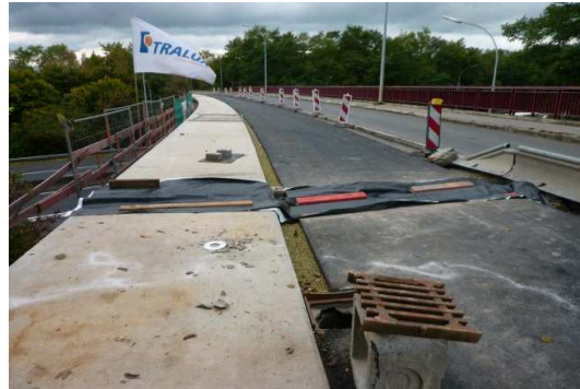
OA 1014 Strassen: élargissement du trottoir en vue de la mise en place de murs de protections pour cyclistes et piétons
