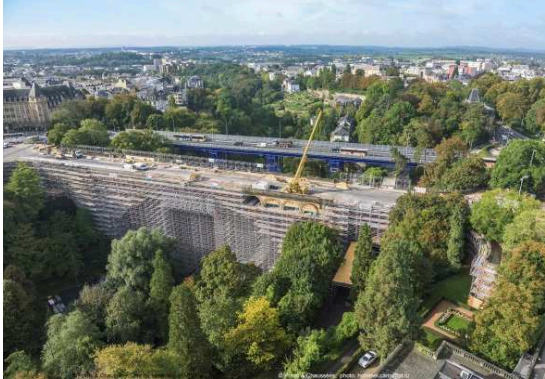
Réhabilitation du pont Adolphe
