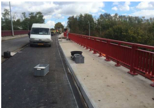
OA 1014 Strassen: remise en état du garde-corps existant
