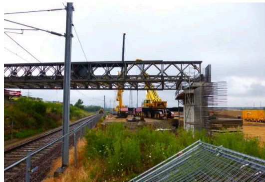
Bettembourg: montage d'un pont provisoire pour les CFL
