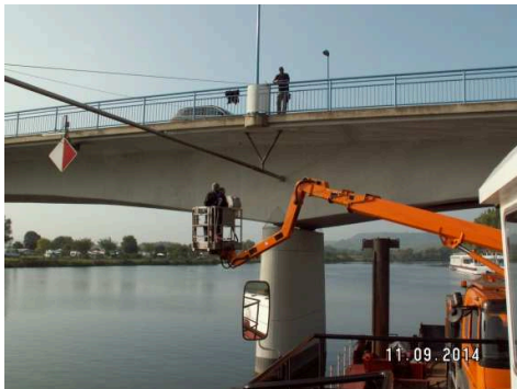
Entretien des balises passives du pont OA 39
