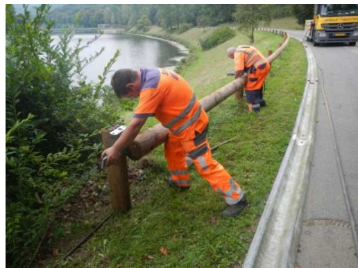
Remplacement des glissières de sécurité à Rosport
