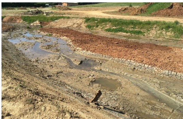
Pendant la phase chantier
