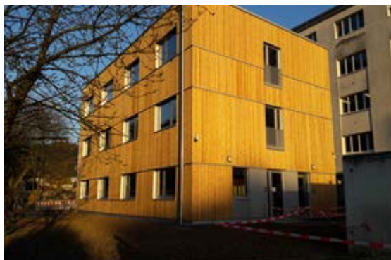
Structure d'hébergement pour DPI à Luxembourg-Mühlenbach
