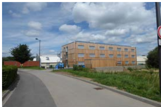
Structure d'hébergement pour DPI à Bettembourg
