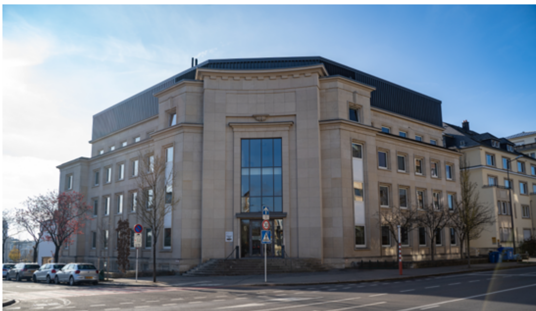
Photo du bâtiment de la direction
