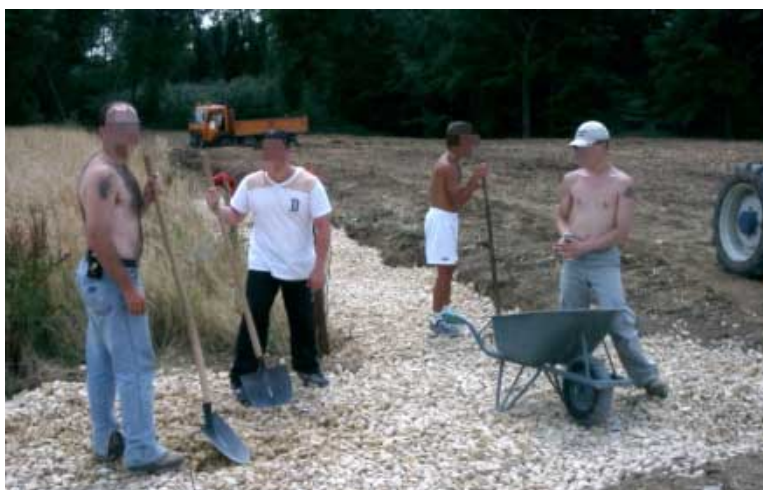
Travaux de terrassement
