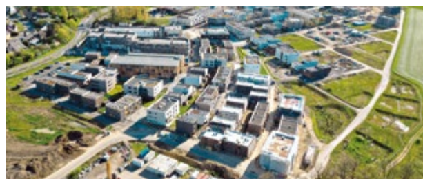
Projet Elmen à Olm © SNHBM / Photographe Flavio da Costa – fagency.lu
