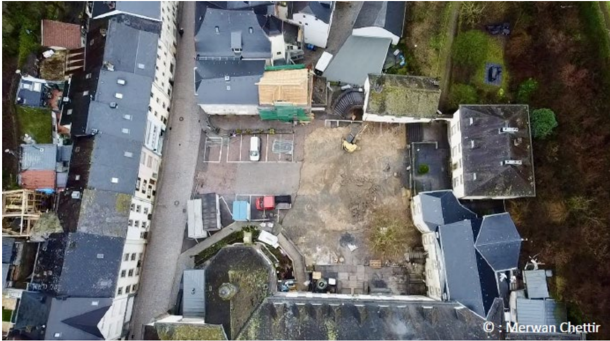
Abb. 4) Luftbild des Place de la Resistance zu Beginn der Arbeiten (Foto Merwan Chettir, ArcheoDiag).
